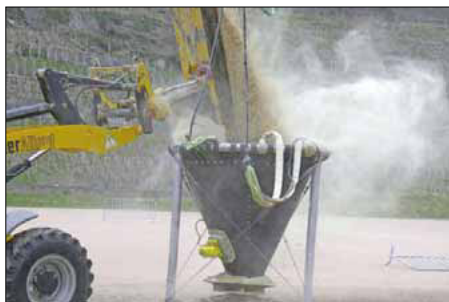
Eine Ladung Kalk wird in den Ausbringtrichter gefüllt.
